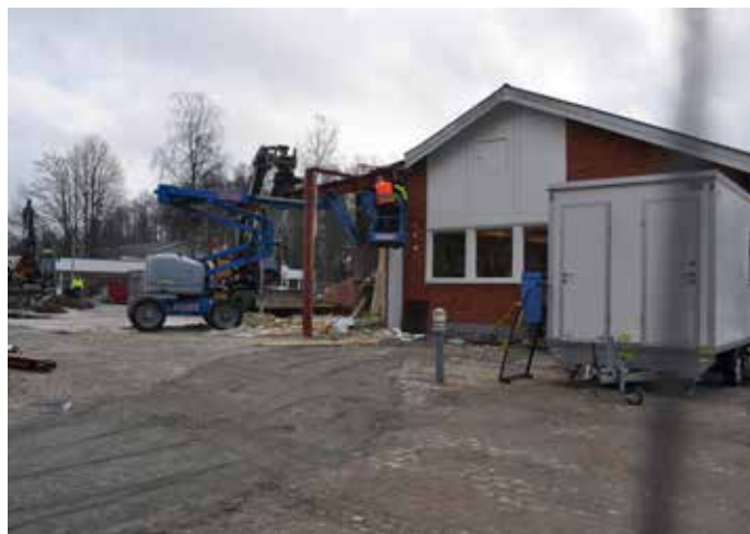
Reparationen av Sandsbro skola är i full gång.
