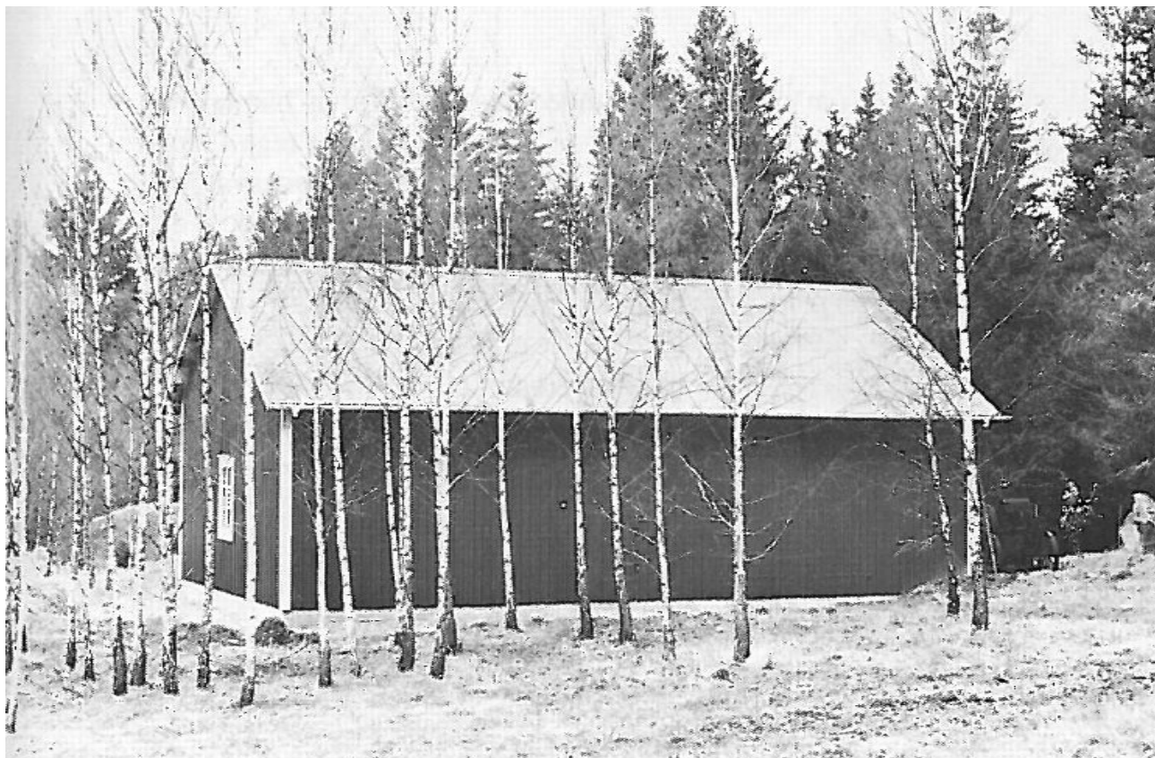
Magasinsbyggnad. Foto år 1981.
