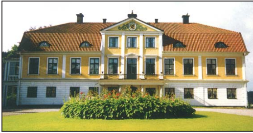
Herrgården idag. Den byggdes 1794 och stenfasaden har en gulvit färg.
